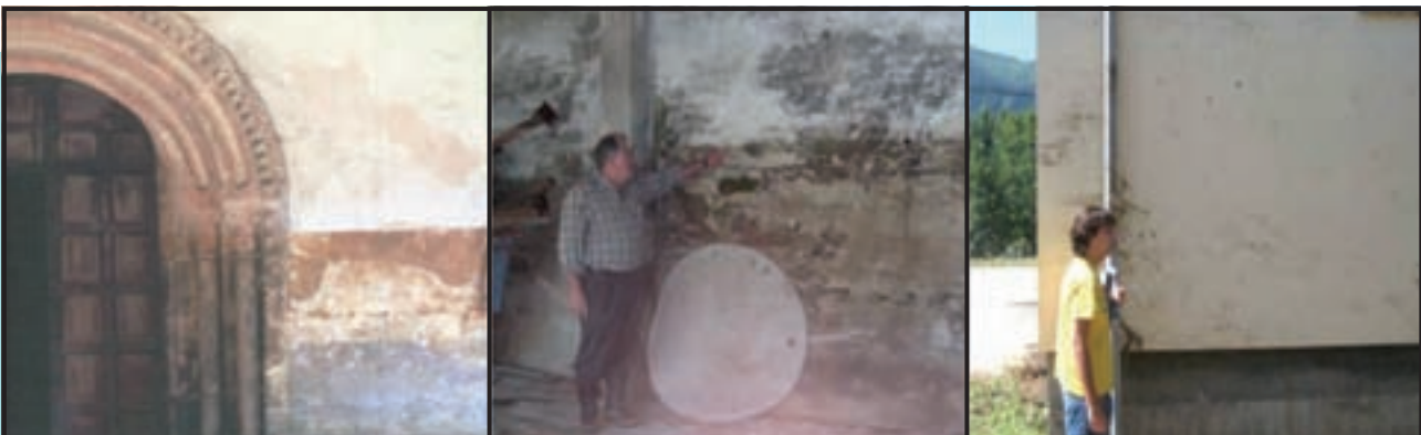
Figura 110. Tintado de fachadas provocado por los sedimentos en suspensión, que aporta valores de alta precisión en el calado alcanzado por las inundaciones (fuente: INDUROT, 2004).
