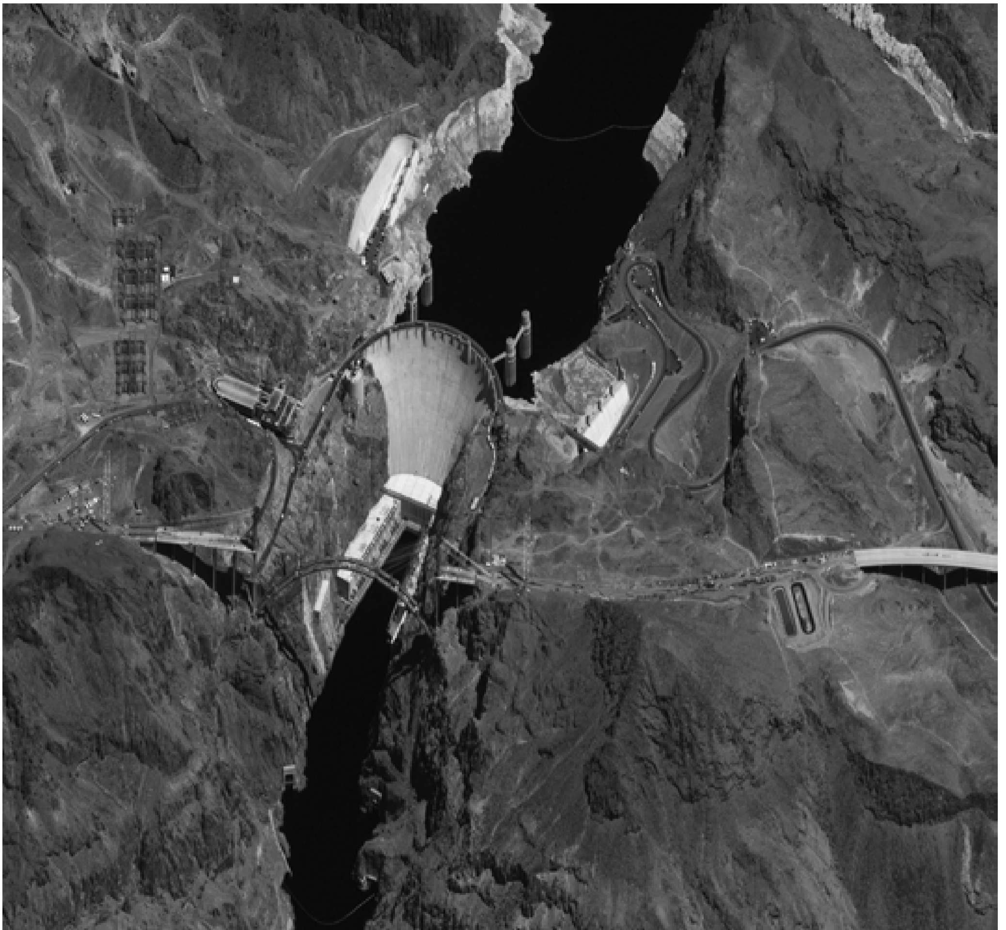
Figura 251: Imagen pancromática, adquirida el 18 de agosto de 2009 por el satélite WorldView-1, sobre la presa Hoover, en la frontera de los estados de Nevada y Arizona, Estados Unidos.
