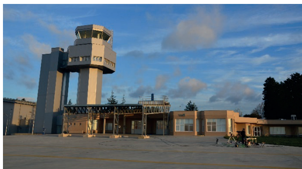
Figura 4. Torre de control y edificios auxiliares. Centro de Investigación Aeroportada de Rozas – CIAR, Castro de Rei, Lugo.
